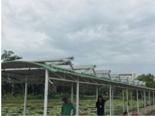
Solar cell : Mono crystalline 3 kW (300 wh x 10)
